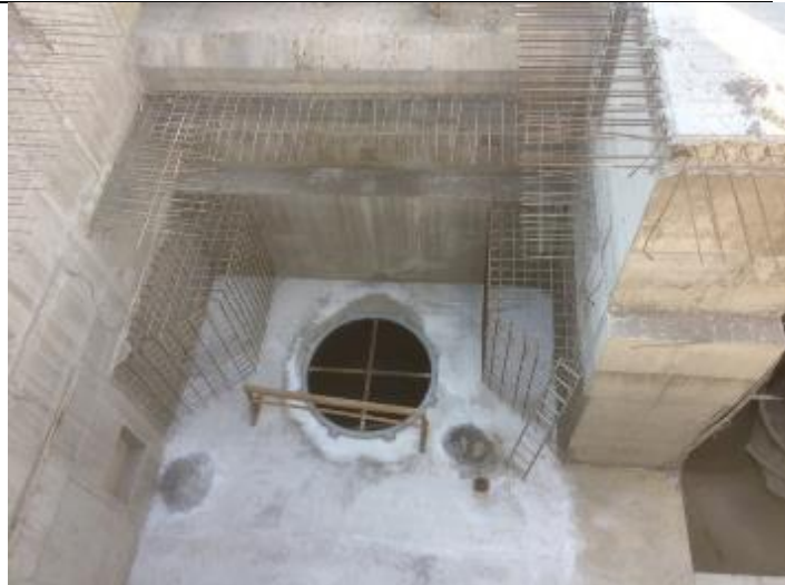
Vista del hormigonado masivo del Difusor U1, lado norte, terminado.
