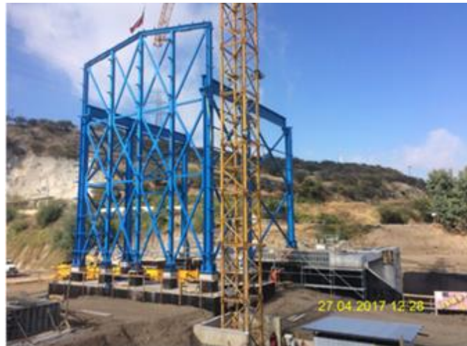
Vista General de la Casa de Máquinas de la CHCV. Avance Superestructura.
