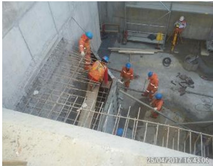
Moldaje y enfierradura e insertos de los Machones de Apoyo a las Turbinas. Son 2 M1 y 2 M2.
