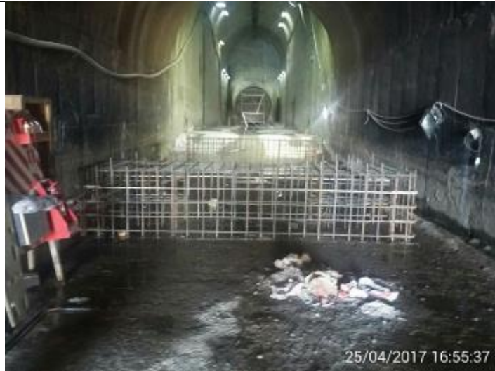
Enfierradura de las Fundaciones F7 a la F15 de la Tubería en Presión de 3.800 mm del Túnel Sur.
