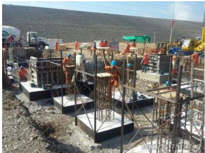
Moldaje y enfierradura Pedestales de la S/E. Se hormigonan los PD5 y 6 de los Pórticos. Son 14 m3 de H30.
