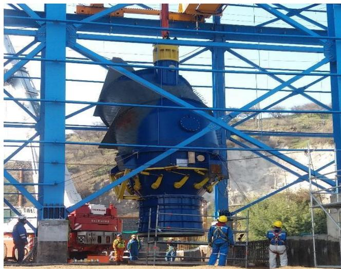
Montaje de la Turbina N° 1 (12-07-2017).
