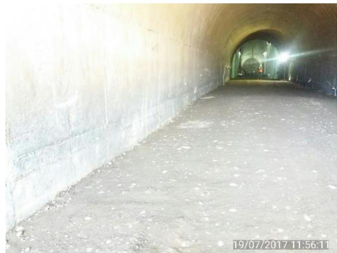
Rellenos Compactados al interior del Túnel Sur, tapando las Fundaciones de la Tubería en Presión, para ingresar con la Válvula de Seguridad de 3800 mm.
