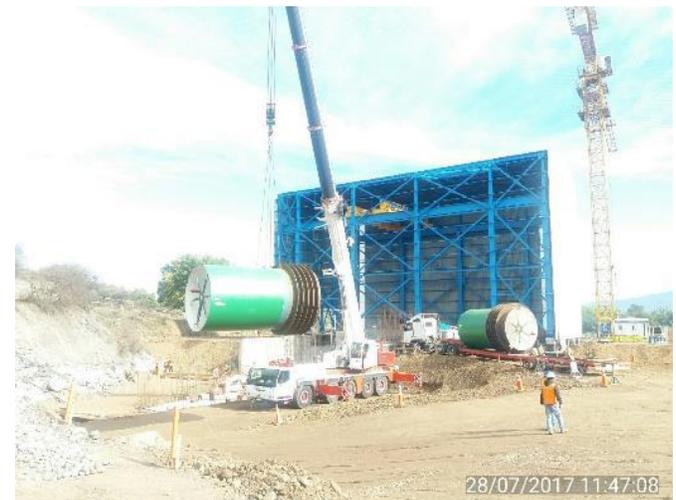
Descarga de tramos de la Bifurcación de la Tubería en Presión.
