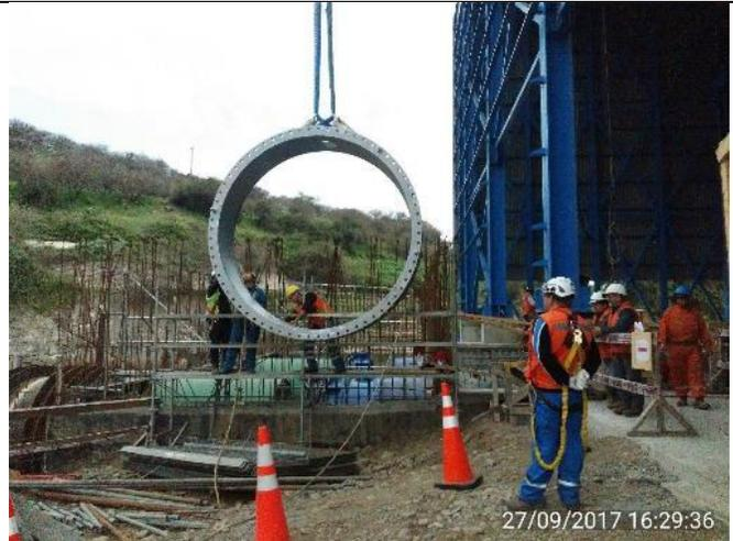
Montaje de Junta de Desmontaje de Válvula Mariposa de la Turbina U1 de la Casa de Máquinas.
