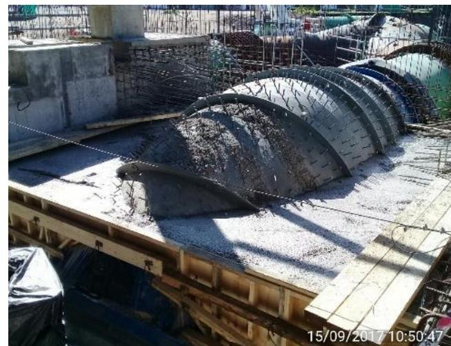
Hormigón de relleno del codo de la turbina 2.
