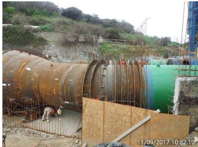
Emplantillado piezas C2 – C4 de la Bifurcación de la Tubería en Presión.
