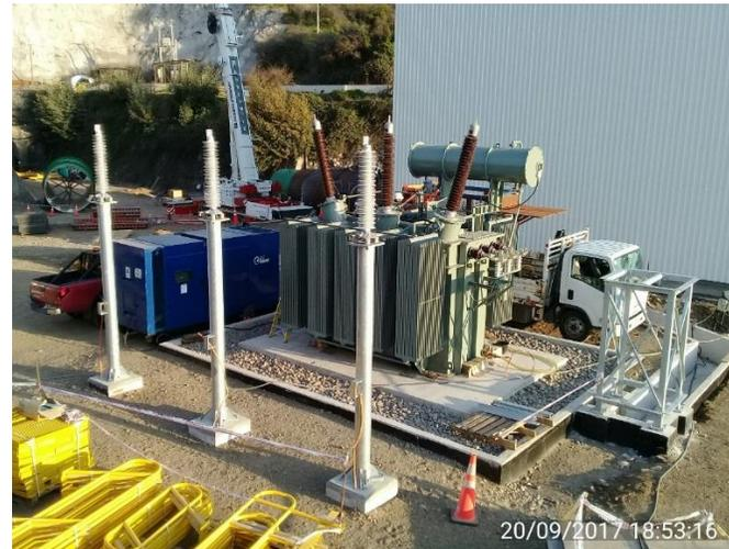
Tratamiento del aceite del Transformador de 20 MVA de la CHCV, por la empresa Rhona. Se aprecian los tres Lighting Arrester (pararrayos).
