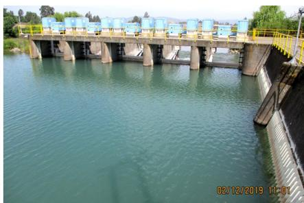
Bocatoma del canal Teno-Chimbarongo (vista hacia las compuertas de la barrera móvil).
