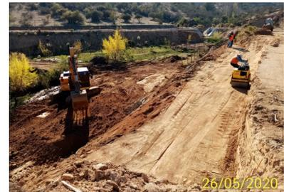
Canal Norte Tramo 2 en Km 34,6, Reparación de talud y reconstrucción del camino de borde.
