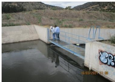
Inspección de aforos de la SCECV 16/03/2021, Estación de medición Descarga a Las Toscas. Caudal aforado: 5,757 m<sup>3</sup>/s.
