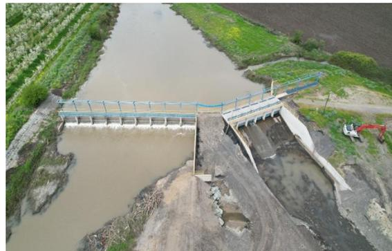
Bocatoma Las Toscas, barreras Stop-Log instalado para peraltar la poza y facilitar captación.
