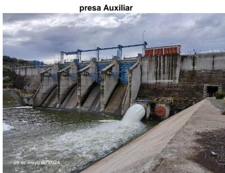
Fecha 29/05/2024. Vista general y funcionamiento de la válvula How-Bunger con 4, 2 m<sup>3</sup>/s para caudal ecológico.
