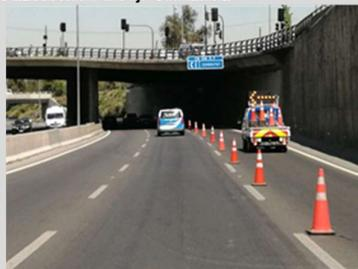
Segregación de berma y pista derecha por trabajos programados de levantamiento topográfico AVO, PK 10700, calzada Sur eje Costanera.
