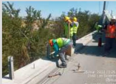
SOP. Km 2.100. Calzada sur, sector La Máquina. Cambio de barreras.
