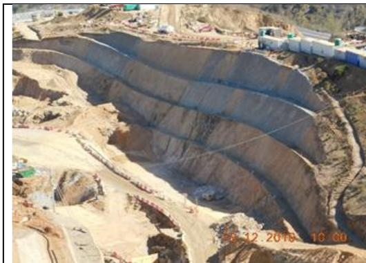
Excavación talud de corte para Eje 4 (Lado Norte)
