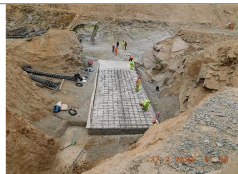
Excavación para atravesio Oriente (Lado Norte)
