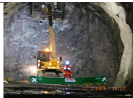
Vista interior del Túnel Sur
