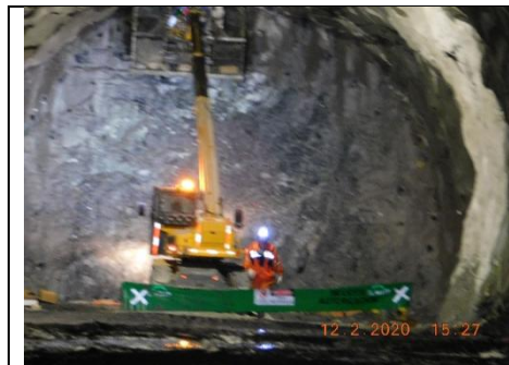
Vista interior del Túnel Sur
