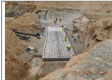
Excavación para atravesio Oriente (Lado Norte)
