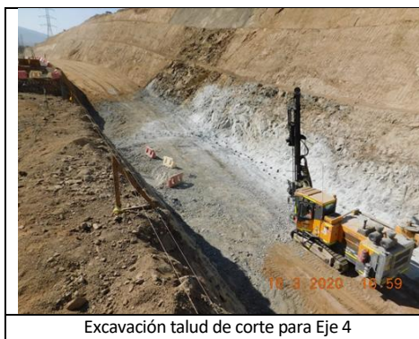
Excavación talud de corte para Eje 4
