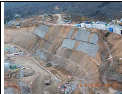
Sector Norte: excavación talud de corte para Eje 4
