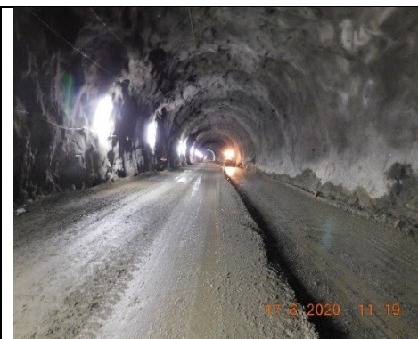
Túnel Norte, pavimento pista derecha
