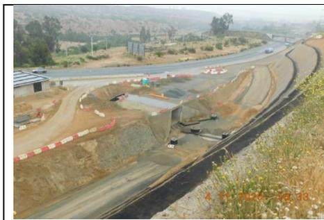
Talud de corte Eje 4, cunetas en banquetas
