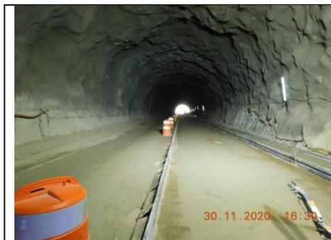
Túnel Sur, preparación de subbase y moldajes pavimento
