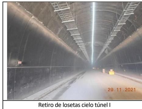
Retiro de losetas cielo túnel I
