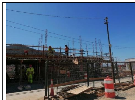
Ampliación edificio de control
