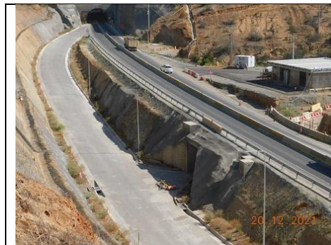
Pavimento Calzada Eje 4, Frente Norte
