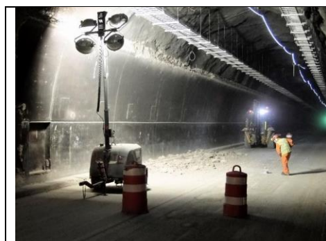
Desbaste coronamiento de Muro Hormigón, Túnel I
