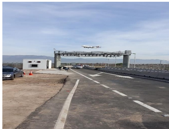
Pórtico sector Portón 12, lado norte
