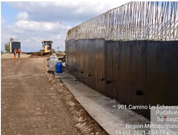
Muro de contención de hormigón armado convencional de entrada sur a PS Lo Marcoleta
