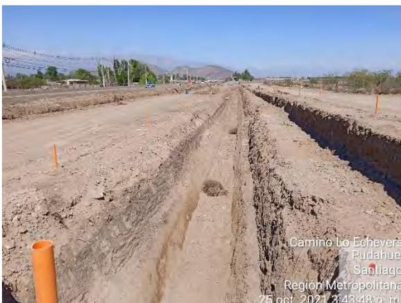
Excavación para alojar foso revestido de 1,50x1,50m en zona norte obra
