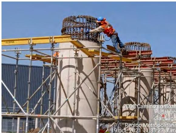
Preparación de armadura de cabezales de pilas para ser hormigonados, formando parte de la viga de apoyo (dintel) en PS Pudahuel Oriente
