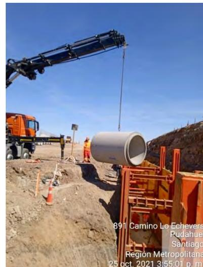
Izaje de tubo de hormigón de 1.450 mm. para ser instalado en colector de aguas lluvia
