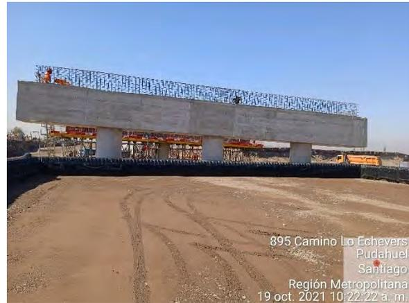
Relleno estructural de muro TEM ya compactado. Se muestra su altura de avance, comparada con estribo de salida PS Pudahuel Oriente
