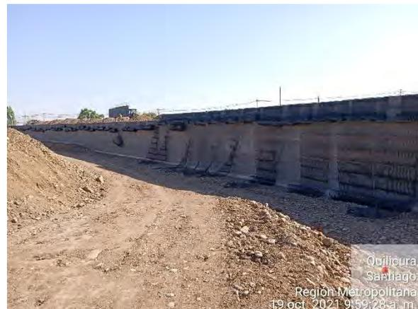
Vista lateral de muro TEM en salida, mostrando la geomalla de refuerzo y el muro de bloques de hormigón, en PS Lo Marcoleta
