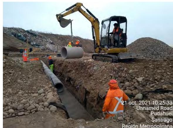
Instalación tubería en sumidero transversal salida norte Paso Superior Pudahuel Oriente
