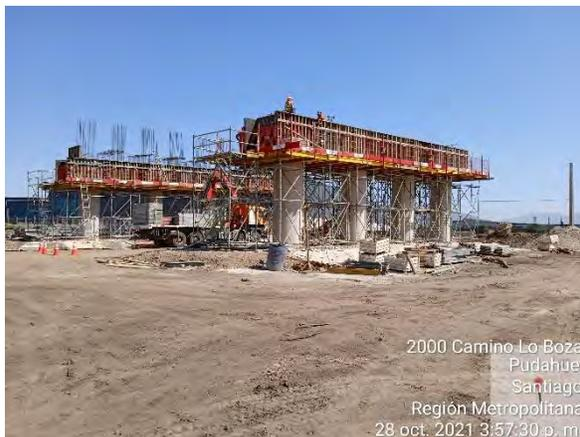
Preparación de moldajes para recibir hormigón que formará parte de la viga de apoyo (dintel) en PS Pudahuel Oriente
