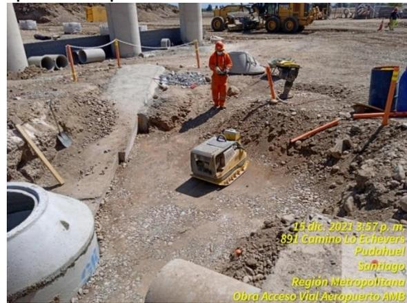
Compactación de relleno de tubería y costado cámara
