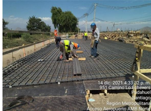
Instalación en enfierradura de losa puente sobre Canal San Luis
