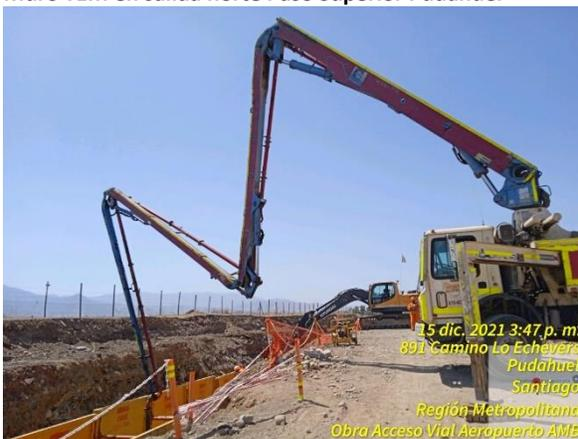
Hormigonado de dado en Colector Pluvial Nro. 1
