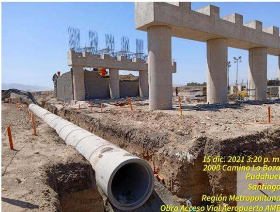
Colector paralelo a lo largo de estructura de Paso Superior Pudahuel Oriente
