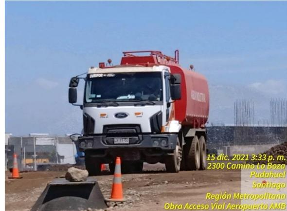
Riego de relleno de muro TEM para mantener humedad óptima de compactación
