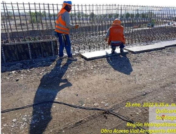
Colocación de armadura en barrera in situ sobre muro TEM
