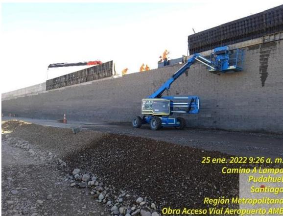
Colocación de moldaje para hormigonar barrera sobre muro de contención
