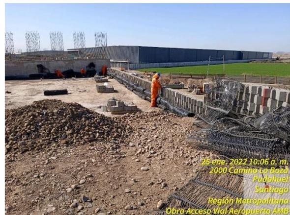
Construcción de muro de bloques en muro TEM salida norte de Paso Superior Pudahuel Oriente
