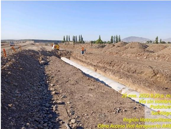
Instalación de tubería de colector pluvial Nro. 1
