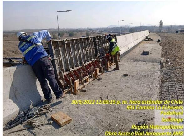
Colocación de moldaje para hormigonar barrera sobre muro TEM. Se aprecia la zapata de la fundación.
