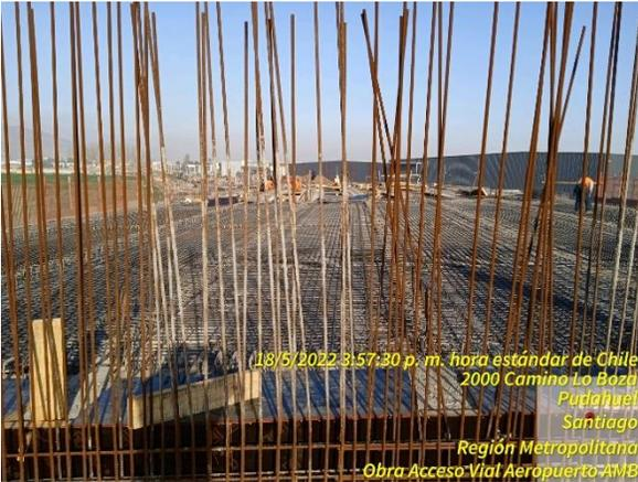
Enfierradura de losa de tablero de Paso Superior Pudahuel Oriente, colocada en posición correcta
