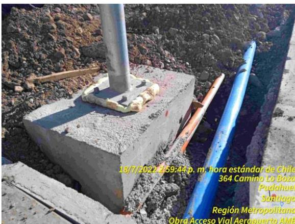
Detalle de fundación de luminaria nivelada con espuma de poliuretano
