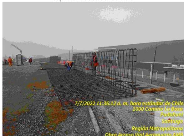
Preparación armadura Muro de contención Canal Sn Luis
