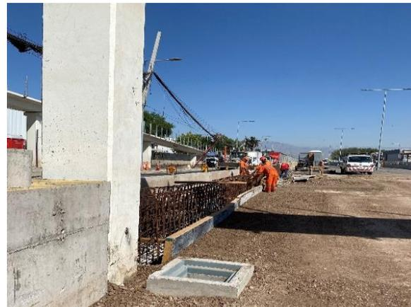
Muro de Contención, Eje B, dm 4.796 a dm 4.833 Colocación de Moldaje
