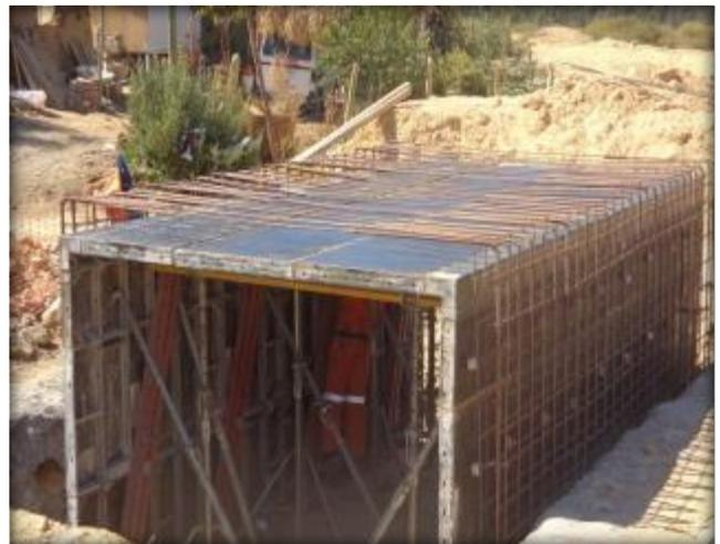
Moldaje para paso predial a hormigonar, km 15.370.
