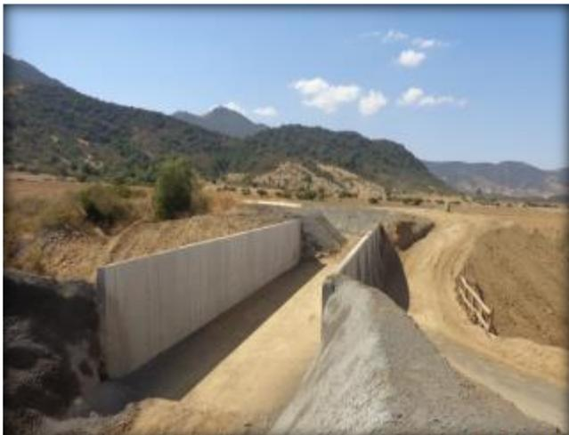
Hormigonado de talud, salida estero El Guaico, Km 8.660.
