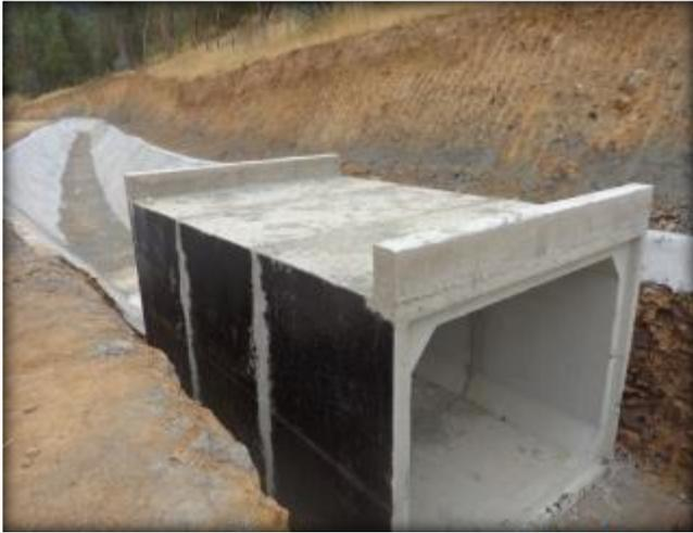
Instalación de cajón para paso predial, Km 14.300.
