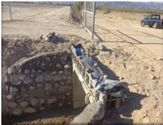
Instalación de portón en acceso al canal y muro guarda
