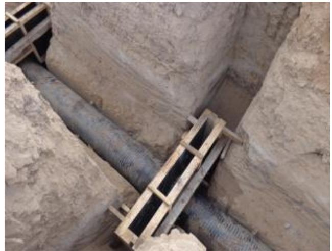
Instalación de tubería para manifold y muros corta gota.
