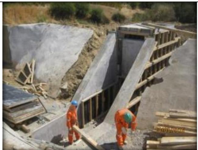
Preparación de enfierradura, descimbre de moldajes y hormigonado de muros, obra de descarga, Estero El Guaico, Km 8,600.
