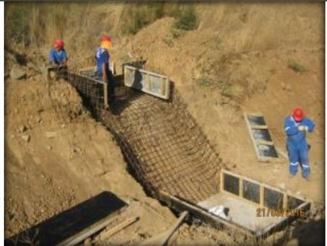
Preparación de enfierradura para descargas a canal.
