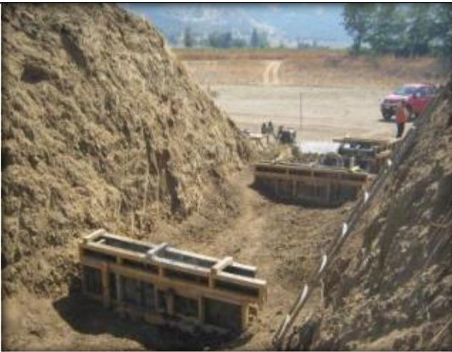
Muros corta gota, relleno estructural y mampostería para manifold, Tranque EL Guaico Oriente, Km 6,960.
