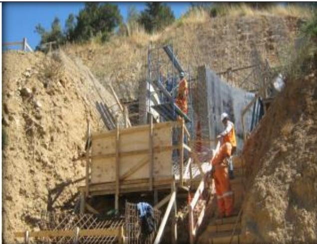
**Preparación de moldajes, obra de descarga.**
