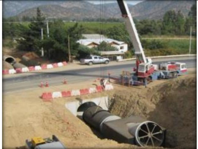
Montaje tubo de acero, obra de descarga.
