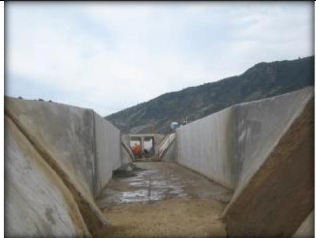
Estero El Guaico, avance en muros de transición (Broken Back), entrada y salida.
