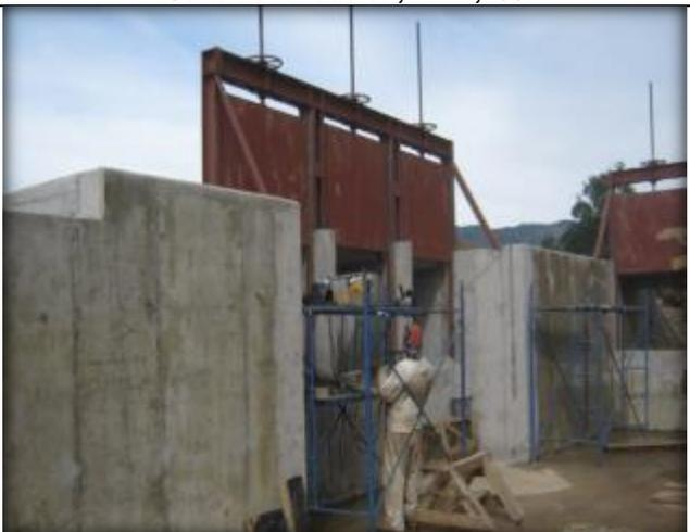
Compuertas, obra de descarga a sifón.
