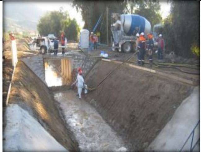
Hormigonado de talud, Km 0,880- km 1,140.
