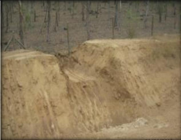
Excavación para descarga de quebrada, Km 18,575.
