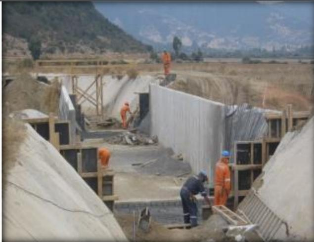
Estero El Guaico, armaduras de muros de transición (Broken Back), entrada y salida.
