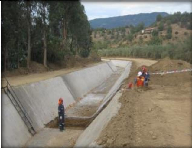
Excavación para descarga de quebrada Tipo 1, Km 0,650.
