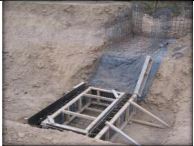
**Preparación de enfierradura y moldajes, descarga de quebrada, Km 17,720 y Km 16,600.**
