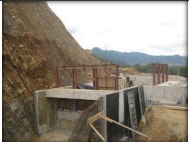
Compuertas, obra de descarga a sifón.
