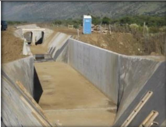
Estero El Guaico, avance en muros de transición (Broken Back), entrada y salida.
