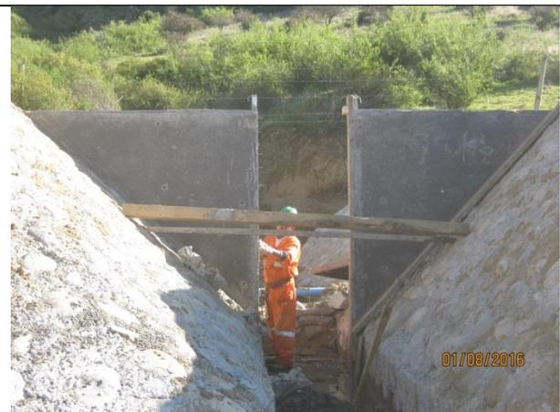
Hormigonado y descimbre moldajes de muros compuerta CQ7, Km. 11,400.
