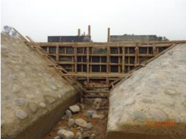
Moldaje Compuertas de Quebrada CQ-7, Km 16,775.
