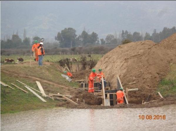
Instalación tubería y moldajes muros corta gotas, Manifold
