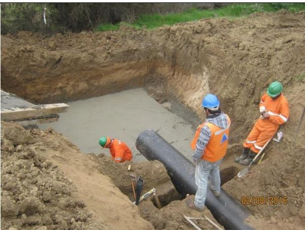
Instalación tubería HDPE, emplantillado y moldaje muros corta gotas Manifold
