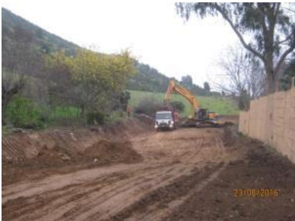
Excavación de Corte y Preparación Plataforma Canal (Km 3,180 – Km 3,420).
