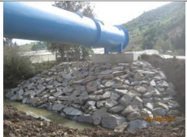
Malla Acma y Enrocado, Estribo Entrada paso aéreo sifón sobre Estero Nerquihue
