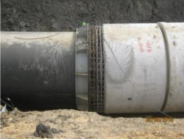
Preparación unión acero/hormigón, curva horizontal C-5 Sifón,
