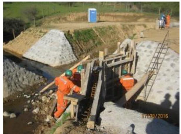
Mampostería badén de salida y preparación moldajes de muros compuerta CQ7, Km 26,555
