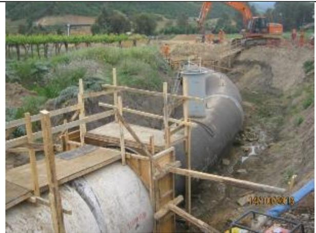
Hormigonado unión acero/hormigón, curva horizontal sifón C-3:(Km. 0,450 – Km. 0,480).
