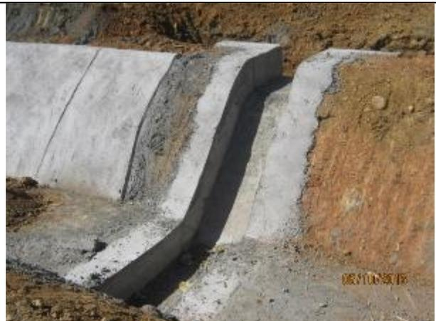
**Hormigonado elevaciones, descarga de quebrada, Km. 3,505.**
