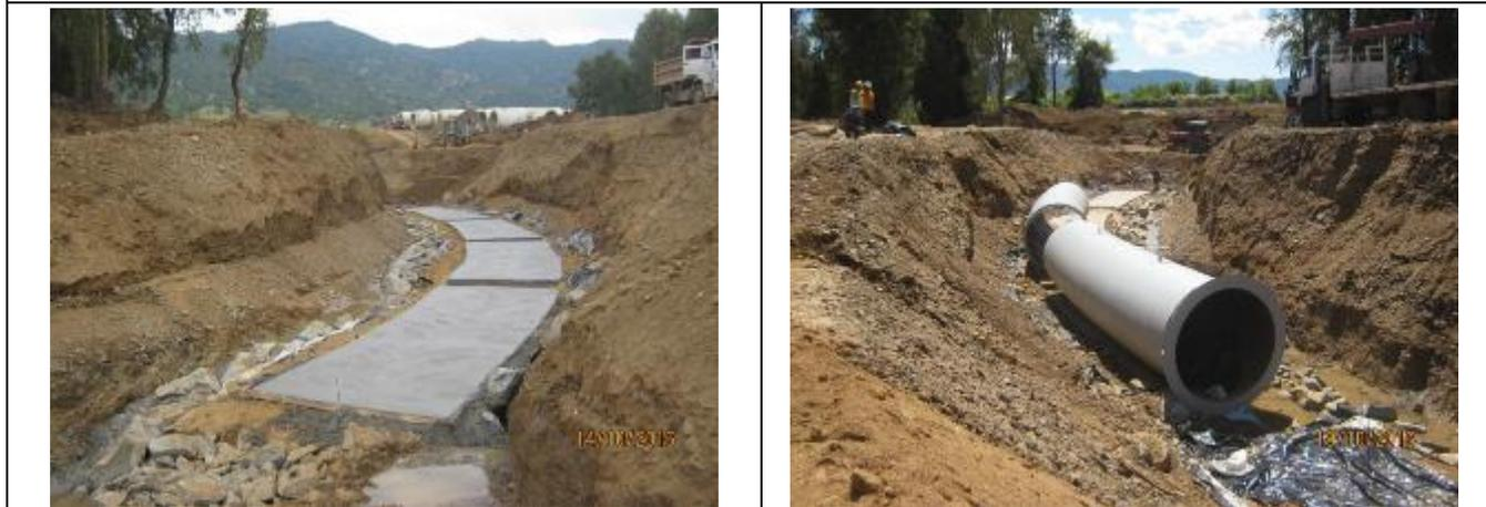
Emplentado fondo canal e instalación tubería acero, curva horizontal sifón C-6:(Km. 1,350 – Km. 1,390).
