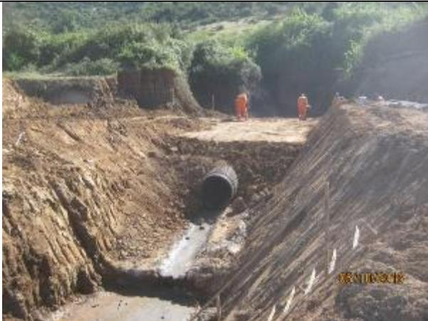
**Instalación de tubería HDPE y relleno estructural, quebrada Km. 17,575.**
