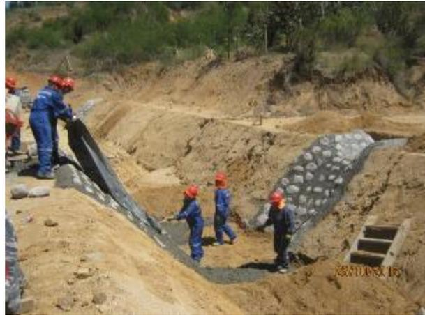
Excavaciones y mamposterías descargas de quebradas: (Km. 31,900 – Km. 32,200).
