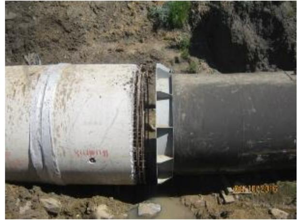
Enfierraduras unión acero/hormigón, curva horizontal sifón C-3: (Km. 0,450 – Km. 0,480).
