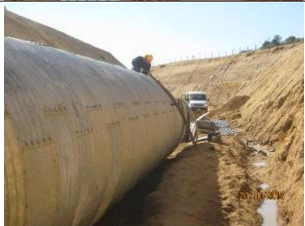
Preparación cama apoyo, instalación tubería corrugada, relleno estructural y torqueo pernos: (Km. 20,700 – Km. 21,000).
