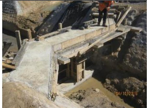
**Descimbre moldajes muros compuerta y mampostería piso CQ7, Km. 41,270.**
