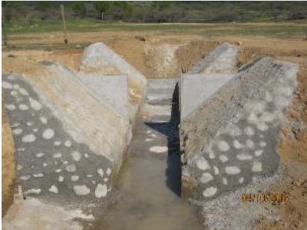
Hormigonado muros compuerta y badén CQ7, Km. 41,620.
