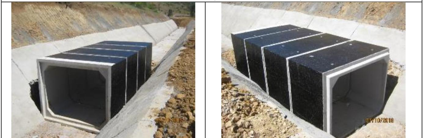
Instalación de cajones y protección bituminosa, acceso a predio, Km. 3,950.
