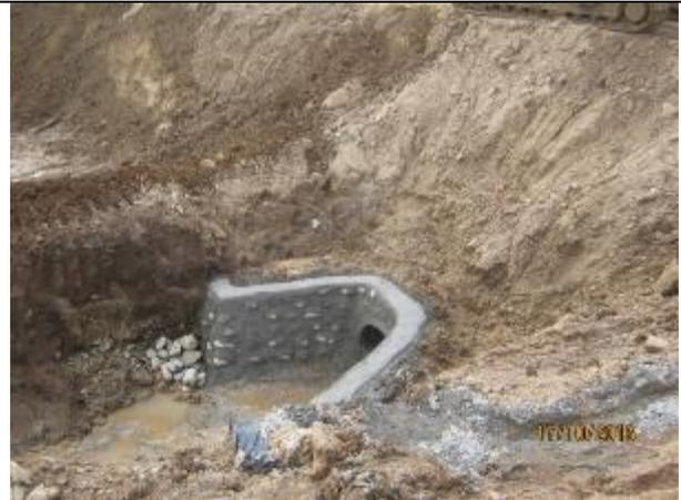
**Conformación de terraplén, corte en terreno y mampostería salida, quebrada Km. 17,575.**
