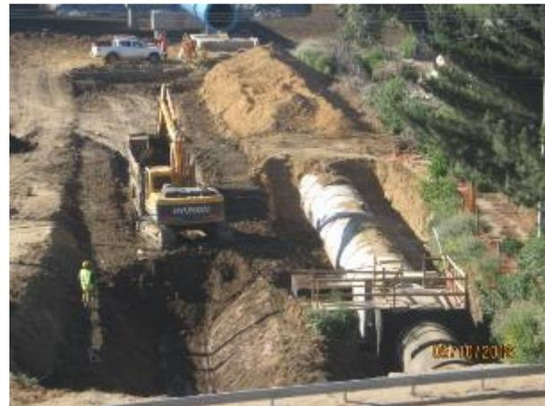
**Excavación de corte en terreno, canal de desagüe obra de descarga.**
