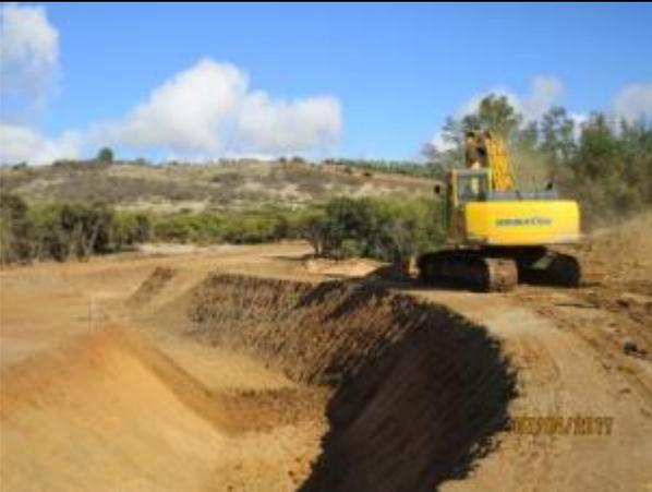
Excavación corte en terreno natural (T.C.N.) de quebrada CQ7, Km 16,705.
