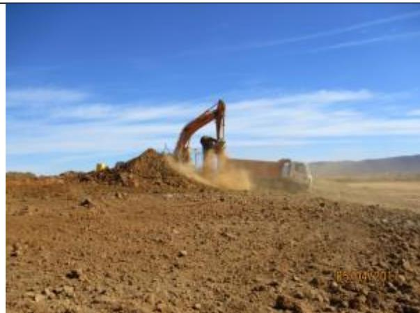
Movimientos de tierra y conformación de pretil en Tranque Las Brisas, Km 49,000.
