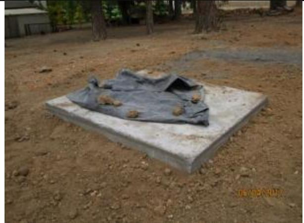
Hormigonado cámara de inspección, tubería HDPE, Km 2,050.
