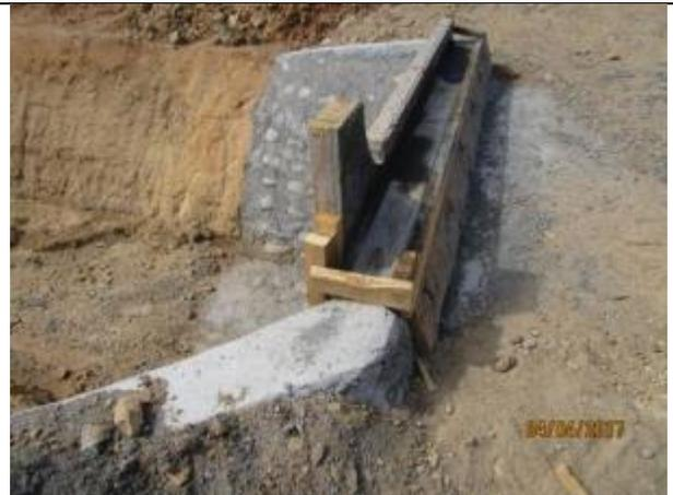
Moldajes y hormigonado muros guardarrueda, acceso a predio, Km 38,980.
