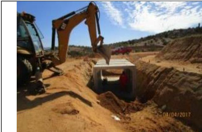
Excavación, emplantado, instalación cajones y emboquillado, acceso a predio, Km 34,080.
