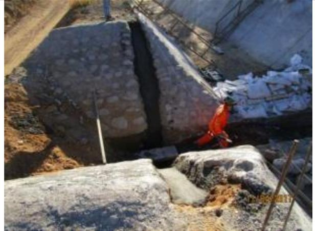
Emplantillado y moldajes, muros compuertas en quebrada CQ7, Km 1,140.
