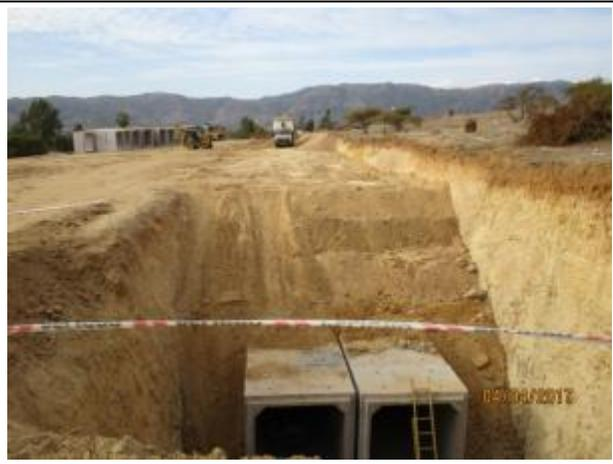
Instalación cajones prefabricados, Km 7,540
