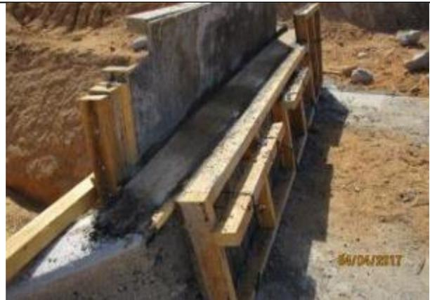
Moldajes, hormigonado muros guardarrueda y mamposterías entradas y salida, acceso a predio, Km 35,500
