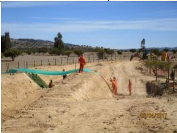
Preparación sello fundación y taludes en quebrada CQ7, Km 56,210.
