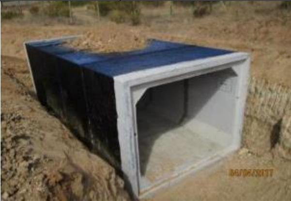
Excavación, emplantado, instalación cajones, emboquillado y protección bituminosa para relleno estructural, acceso a predio, Km 38,500.
