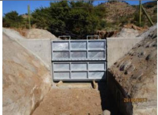
Hormigonado muros e instalación compuerta en quebrada CQ7, Km 5,345.
