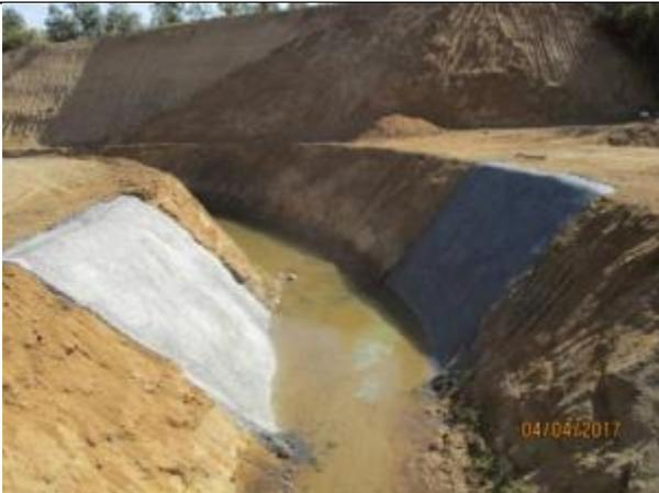
Revestimiento protección, tubería HDPE quebrada, Km 31,380.
