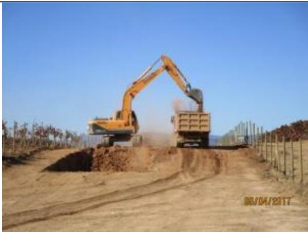
Instalación de cercos y preparación de plataforma (Km 53,500 – Km 53,960).
