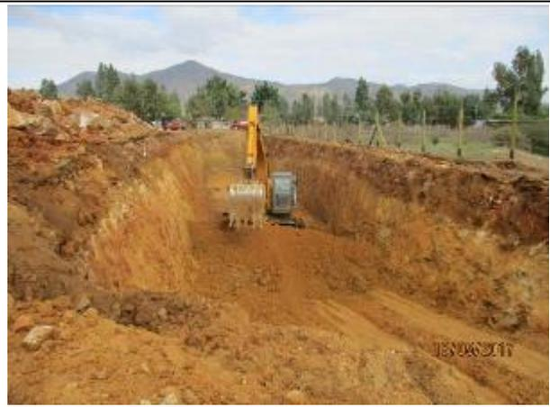
Excavación de corte en terreno de cualquier naturaleza T.C.N., para cajones prefabricados (Km 8,050 – Km 8,370).
