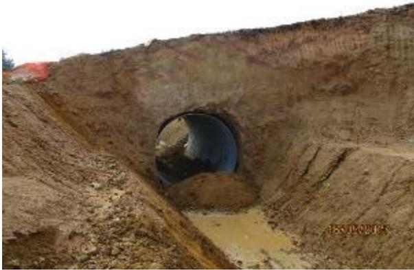
Excavación e instalación de túnel liner, Km 7,741
