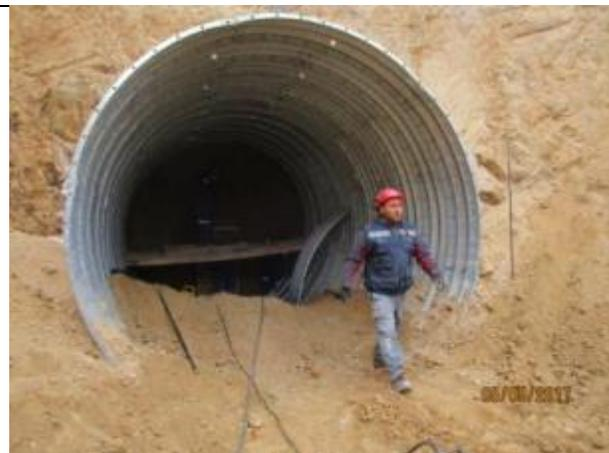
Excavación e instalación placas túnel liner (Km 7,560 – Km 7,580).
