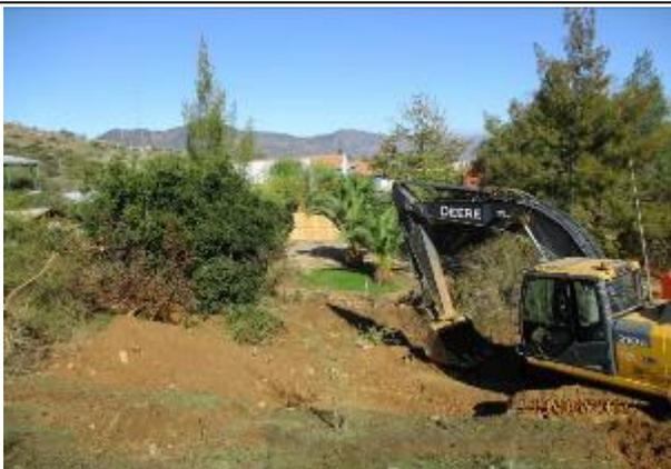
Excavación de corte en terreno de cualquier naturaleza (T.C.N.), para cajones prefabricados, Km 7,020
