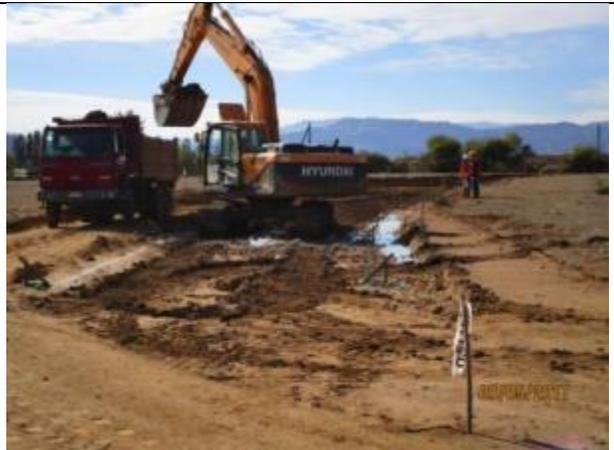
Excavación de corte en terreno de cualquier naturaleza (T.C.N.), emplantillado e instalación cajones, acceso a predio, Km 53,270
