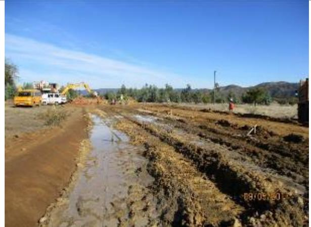
Excavación de corte en terreno de cualquier naturaleza (T.C.N.), emplantillado e instalación cajones, accesos a predio, Km 53,080.
