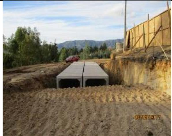
Instalación de cajones prefabricados (Km 7,720 – Km 7,750).
