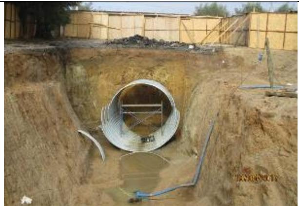
Excavación e instalación de túnel liner, Km 7,565
