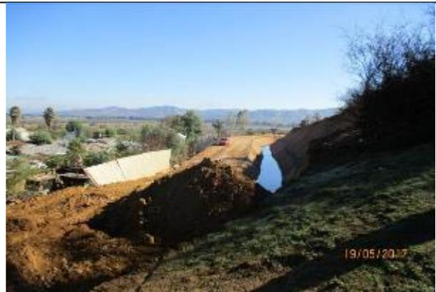
Excavación en corte en terreno de cualquier naturaleza (T.C.N.), para cajones prefabricados, km 7,020
