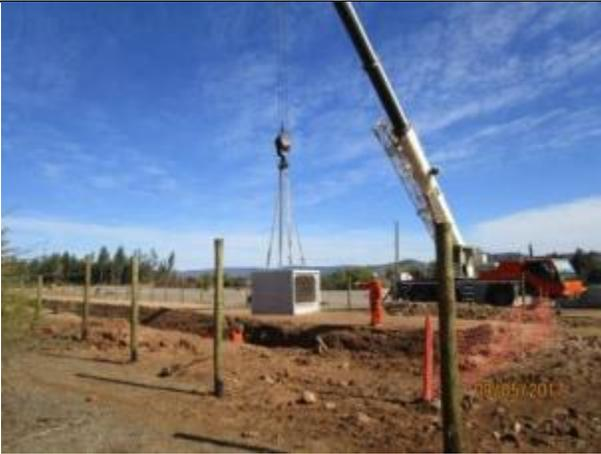
Excavación de corte en terreno de cualquier naturaleza T.C.N., emplantillado e instalación cajones, acceso a predio, Km 53,470
