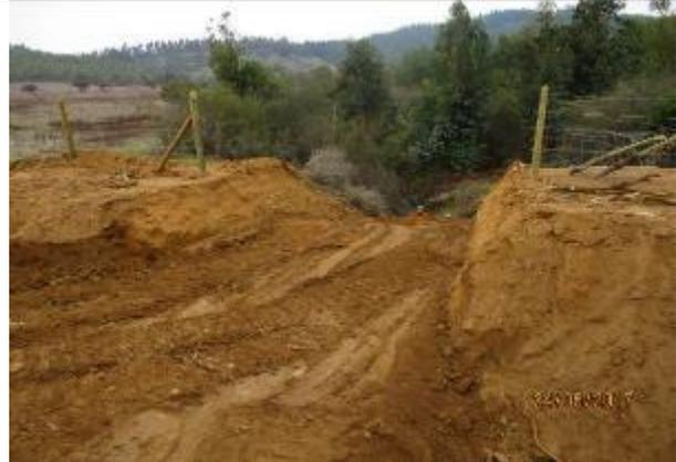
Instalación de tubería HDPE diámetro 1,0 m en cruce de quebrada, Km 46,940.
