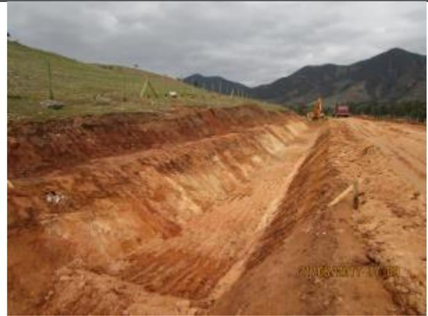
Excavación corte de canal (Km 8,740 - Km 8,800).
