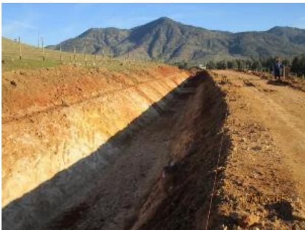
Excavación corte de canal y revestimiento (Km 8,640 – Km 8,720).
