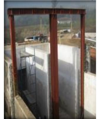
**Insertos metálicos para compuertas.**
