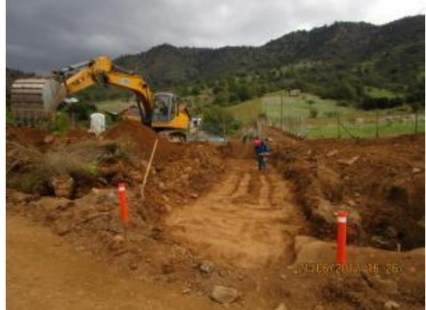
Instalación de tubería HDPE y compactación de terraplén cruce de quebrada, Km 3,170.
