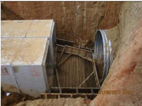
Instalación armadura losa inferior, transición entrada y salida Túnel Linner, Km 7,440.
