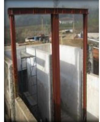
**Insertos metálicos para compuertas.**
