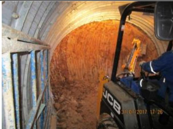
Armado y excavación de túnel liner, Km 7,770.
