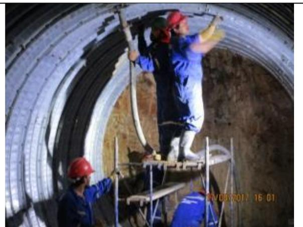
Excavación e Inyección de tunel Linner, Km 7,780.
