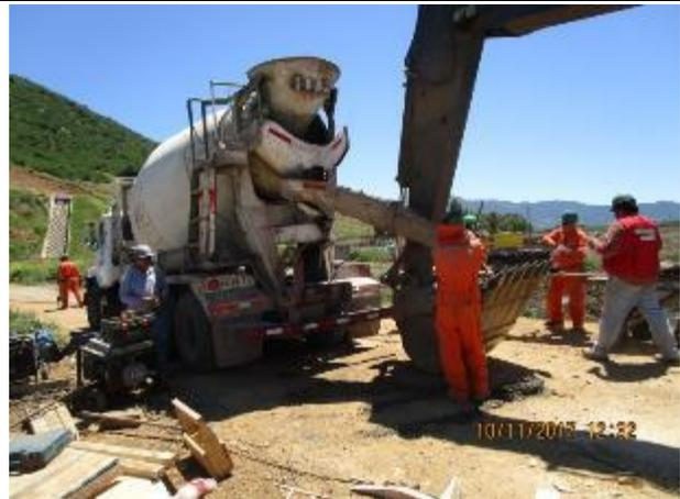
Instalación de armadura, moldaje y hormigón dado de unión flexible polimérica en curva C2.
