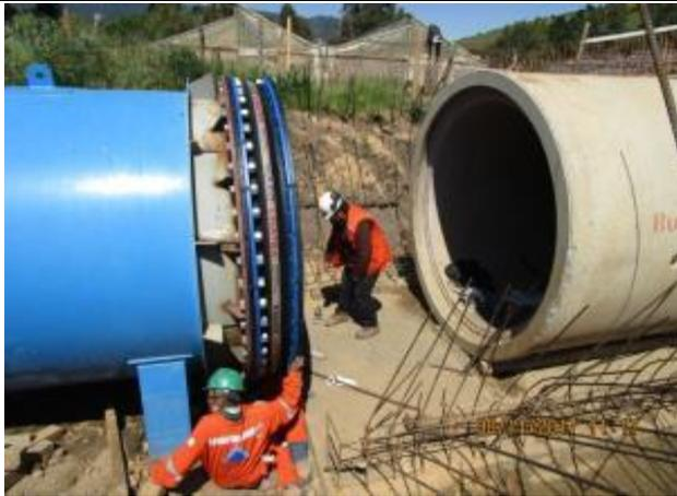
Instalación de Unión flexible polimérica bridada, en curva C2, Km 0,140
