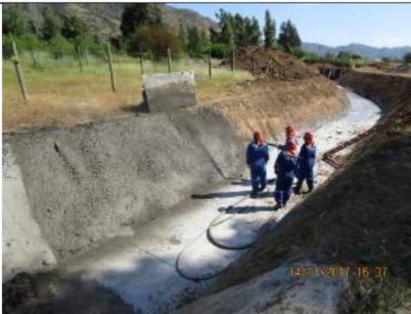
Revestimiento de taludes (Km 5,700 – Km 5,840).
