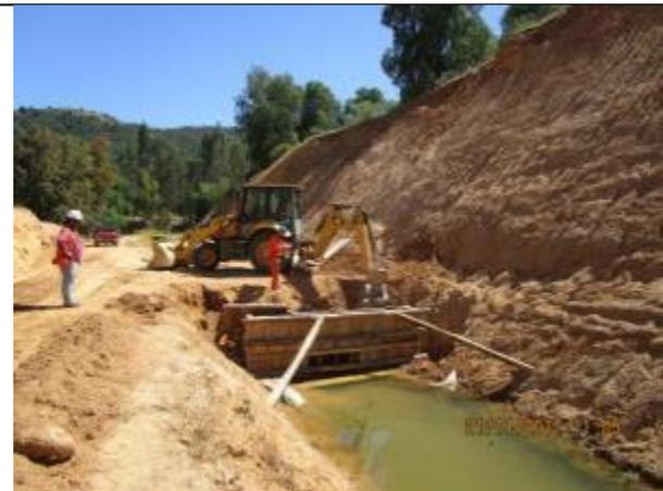
Instalación de tubería HDPE para solución provisoria, en zona de derrumbe, Km 22,500.
