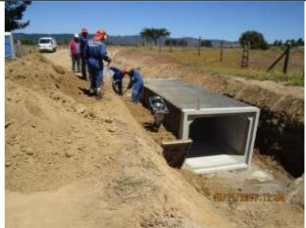
Instalación de cajones y relleno estructural paso predial, Km 46,680.
