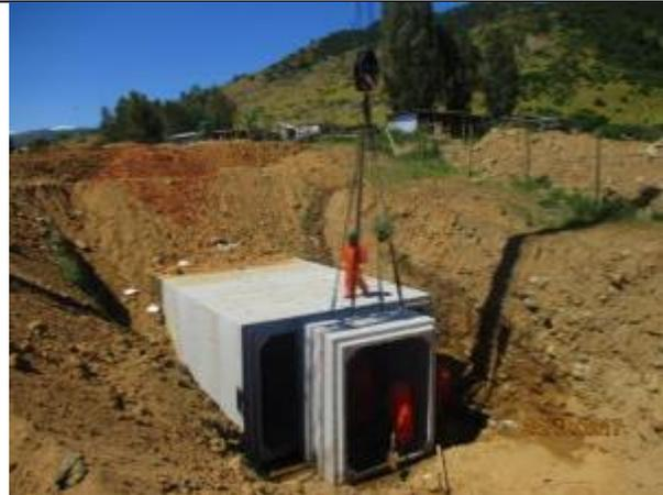
Montaje de Cajones Prefabricados, Km 8,450.
