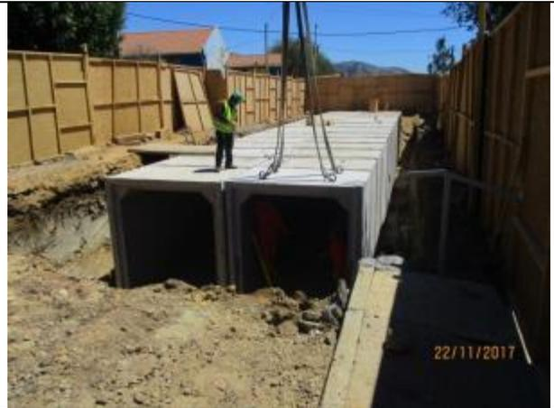
Instalación de cajones prefabricados (Km 7,150 - Km 7,180).
