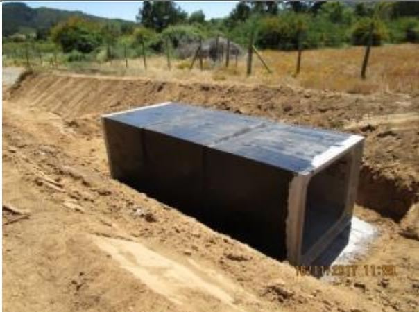
Instalación de cajones y relleno estructural paso predial, Km 44,940.
