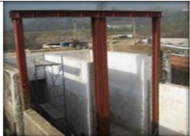
Insertos metálicos para compuertas.
