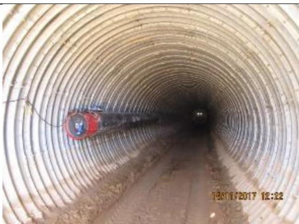
Trabajos en sistema de ventilación y armado de túnel Linner, Km 7,800.
