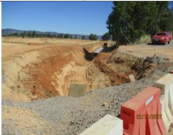
Excavación corte de canal, Km 48,640.
