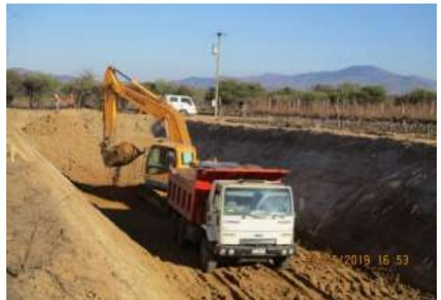
**Canal El Molino;** Excavación mesa de canal km 2,350. Este se excavará a partir de la actual cota de fondo de la excavación.
