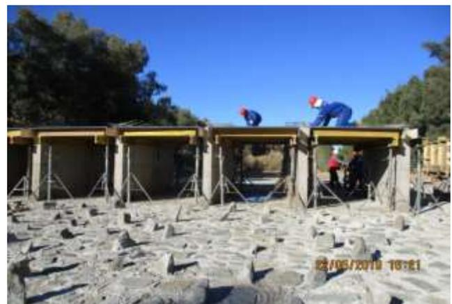
**Canal El Fondo; Poza Quiahue 1, instalación de encofrado y armadura de la losa superior de los cajones.**
