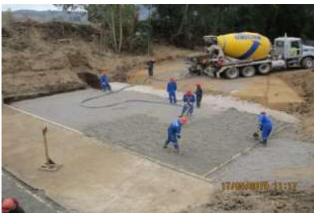
**Canal El Molino ;** Poza quiahue 2, vaciado de hormigón en radiers de lados oriente y poniente de la barrera transparente, a construir en la sección central.
