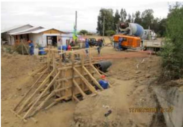
**Canal El Fondo;** Vaciado de hormigón cámara de entrada del Sifón del km 1,700.
