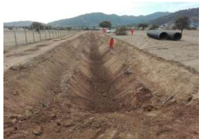
**Canal El Fondo; Corte de canal y escarpe (km 3,300 – km 3,500).**
