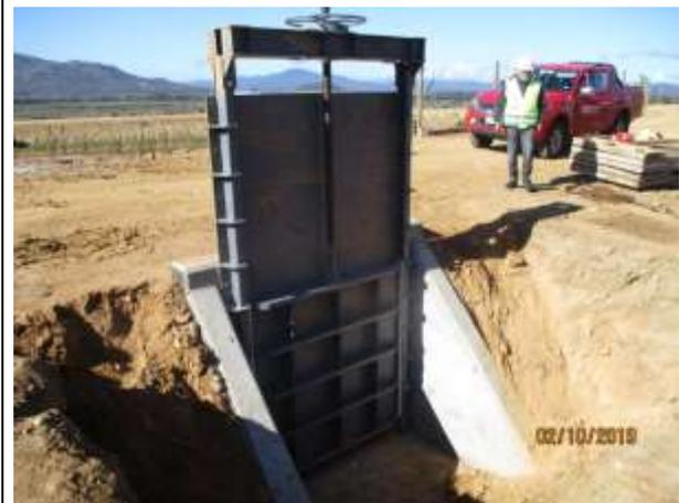
**CS Tramo 2; Tranque Monterina Sur;** instalación de compuerta, nueva descarga canal a tranque (km 22,765).
