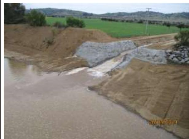
**NCS; ramal “El Molino 1”;** Estero Quiahue, perfilado taludes, sector descarga (km 1,690).
