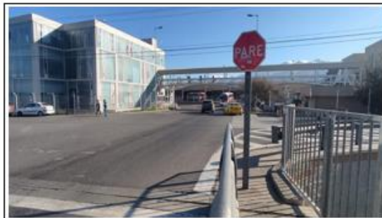
4. Vista PTLA desde Puente Acceso
