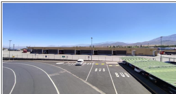
4. Vista General Zona Andenes
