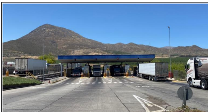
6. Vista Casetas Acceso - Egreso PTLA
