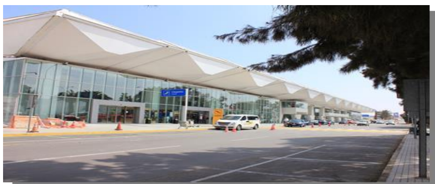
Figura 1: Frontis Edificio Terminal Aeropuerto Cerro Moreno.
