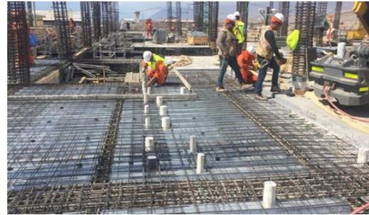
**Trabajos de enfierradura en losa cielo primer nivel
