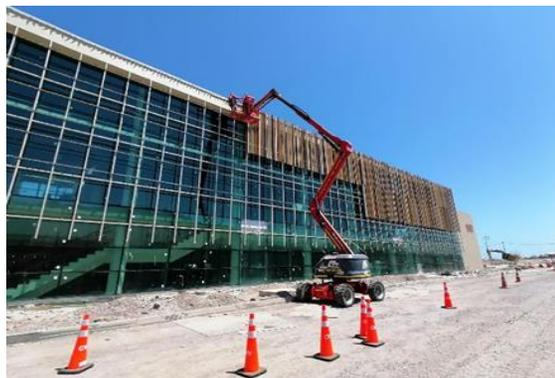
Instalación Estructura Metálica Soporte y Lamas de Celosías de Fachada Edificio de Pasajeros(Ampliación)
