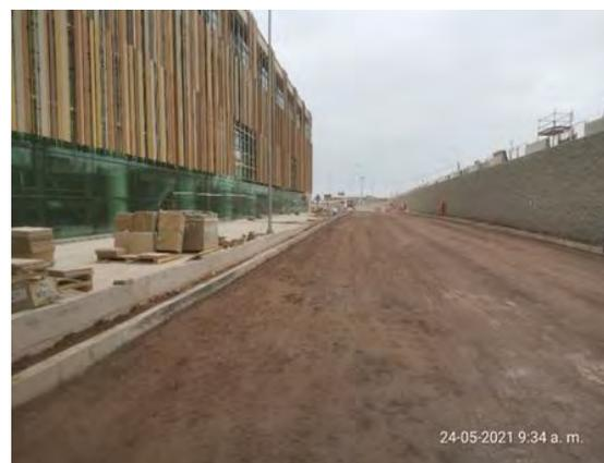
Obras en vialidad sector Edificio Terminal, Colocación y compactación de estabilizado Calle Piso 1, Dm.120 al Dm. 200
