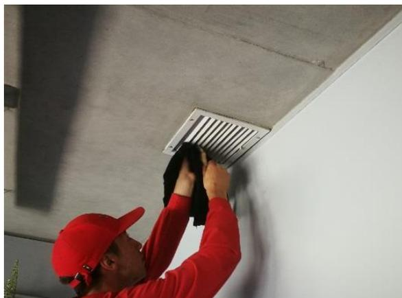
del recinto, se resumen principalmente en la revisión de luminarias, limpieza y mantención de los ductos de ventilación. Art. N° 2.2.4.7 y 2.2.9 del PACO respectivamente.
