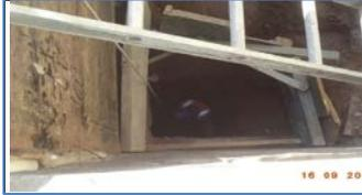
Se realiza excavación para fijar nuevo apoyo en el sector de Cámara Eléctrica del Edificio de Guardia Interna.
