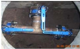
Reemplazo de pieza y válvulas para reparación de agua potable pasillo de circulación visitas.
