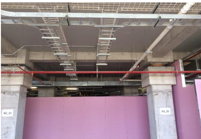
Avance losa hormigonada en edificio UPC
