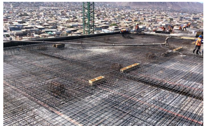
Avance losa nivel 8 edificio TH
