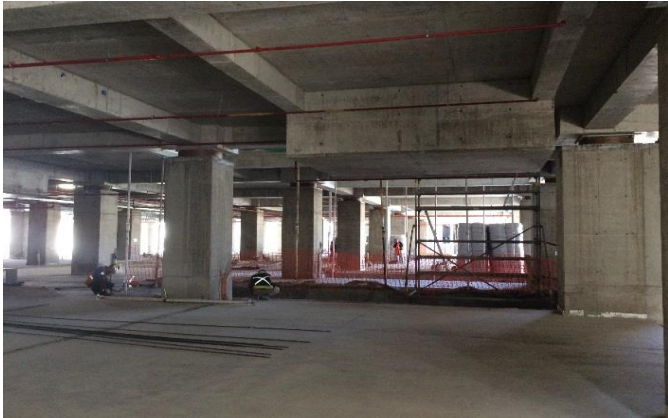
Grout en capiteles edificio CDT
