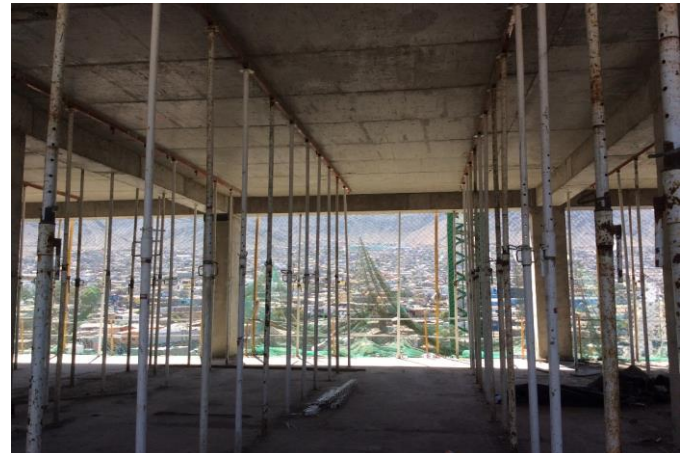
Avance losa nivel 7 edificio TH
