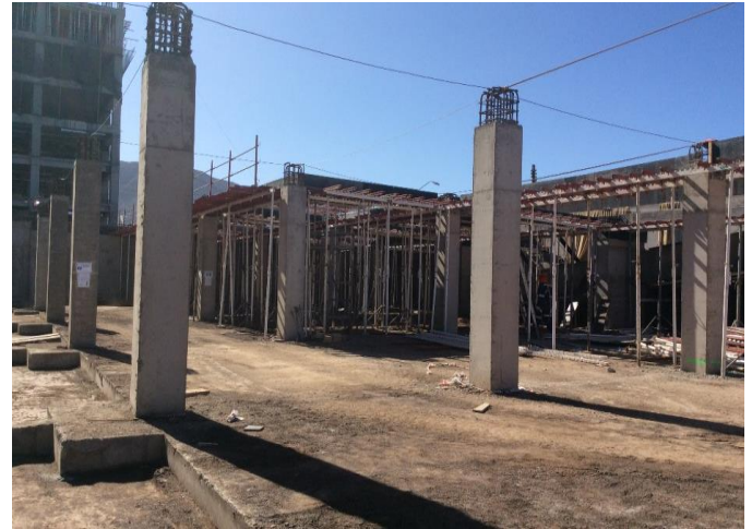
Control de enfierradura estacionamiento unidad de emergencia
