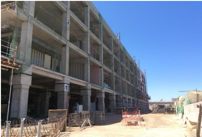
Avance en la colocación de hormigón en edificio Unidad de Pacientes Críticos UPC
