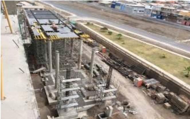
Armado y Hormigonado de columnas de cafetería
