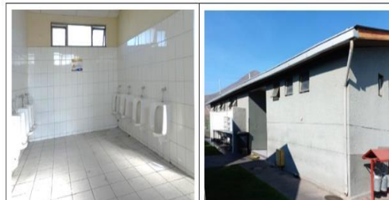
Verificación del área de Baños y Duchas Choferes N° 1.
